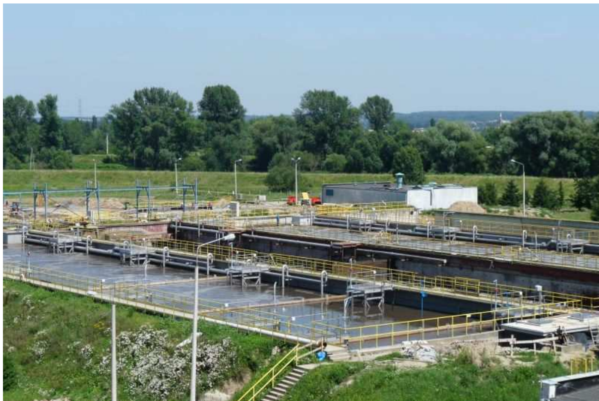
Teren oczyszczalni ścieków.
